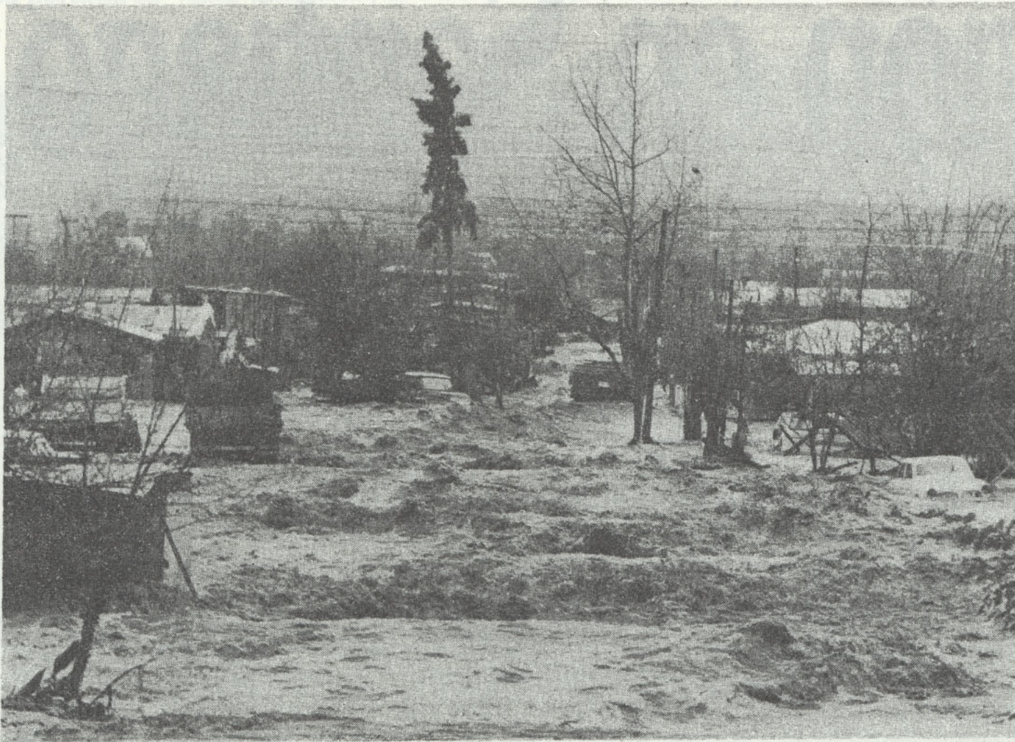
ESTRAGOS DEL TEMPORAL. La población Lo Hermida, de la comuna de Ñuñoa, resultó seriamente afectada debido a que las aguas del canal San Carlos se vaciaron hacia ella. Miles de habitantes debieron ser evacuados y trasladados hasta el Estadio Nacional. Por la noche, muchos vecinos del sector llegaron hasta el lugar para entregar viveres y recursos a quienes perdieron su vivienda
