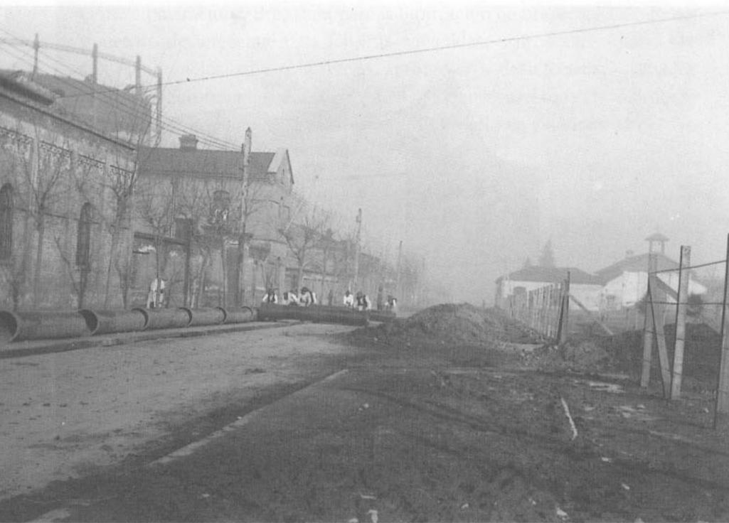
*Instalación de cañerías de distribución de gas a la salida de la Fábrica San Borja, 1927*
