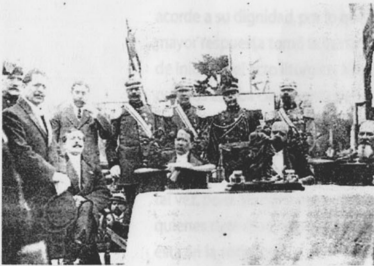
Acto oficial de las fiestas. Colocación Primera Piedra monumento en Maipú. Fuente: Calderón (1973).
